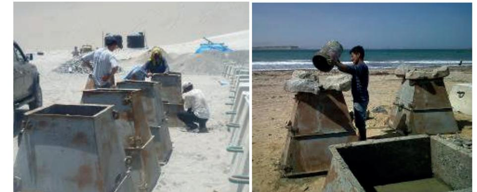
Figura N° 22: Armado de moldes y vaciado de concreto para lastres (FONDEPES-OSPAS –Región Ica, 2012)
